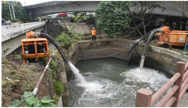
圖 6 支援桃三灌區移動式抽水機抽水情形
